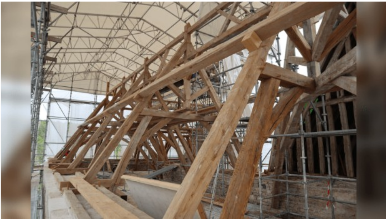
Charpente – couverture : Les Charpentiers de Bourgogne
